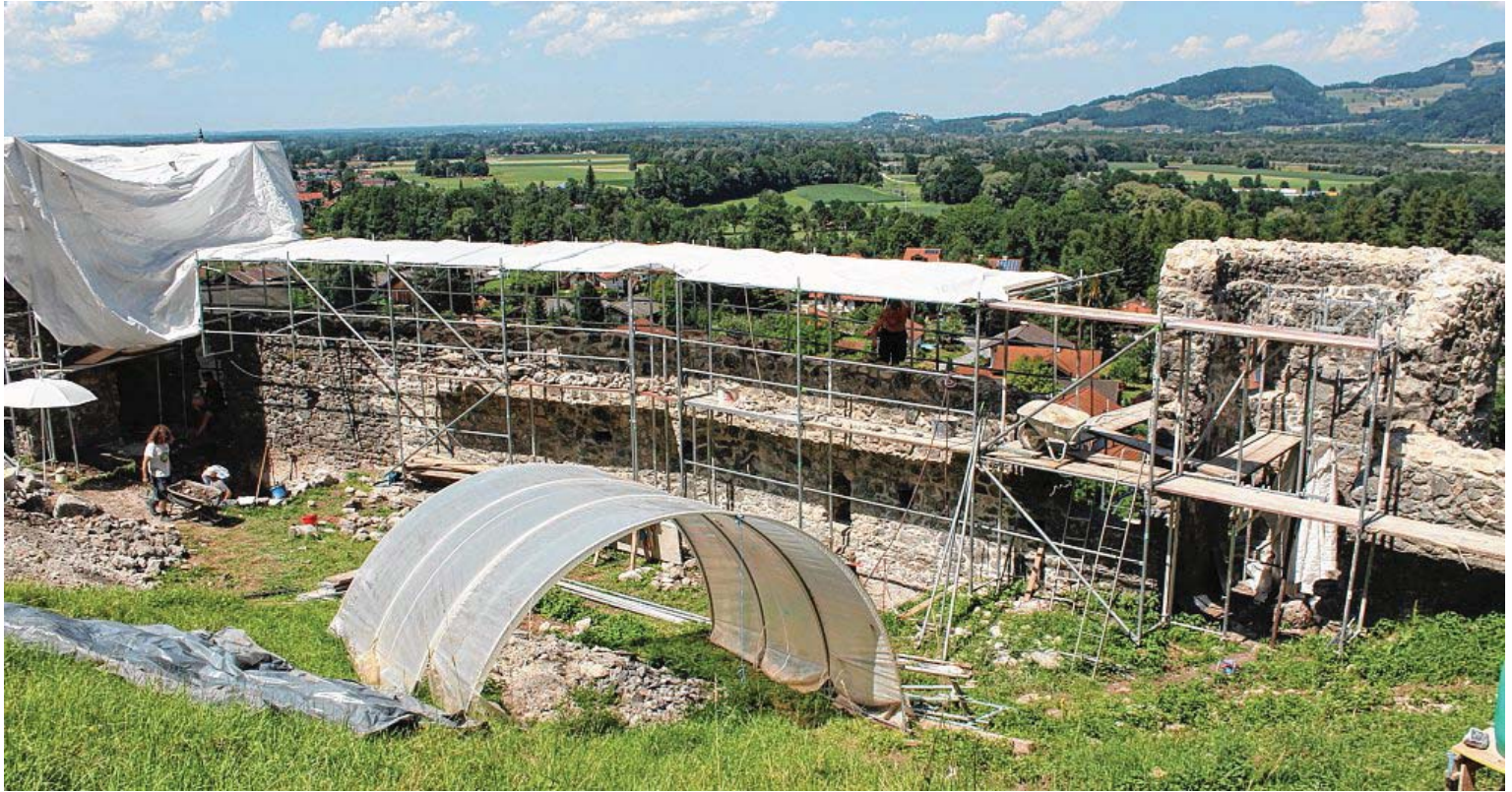
Aktuell finden auf dem Gelände der Burg Falkenstein in Flintsbach Renovierungsarbeiten und Sicherungsmaßnahmen statt. Archäologen legen derzeit den Bereich der Ringmauer frei und entfernen dort das Erdreich, um den Druck von der Mauer zu nehmen.
