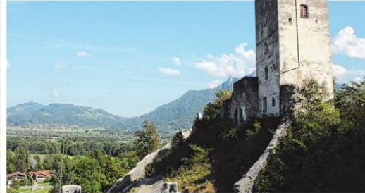
Dieser Mauerabschnitt wurde als erster saniert.
