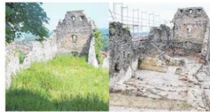
Burg Falkenstein vor Beginn der Arbeiten (links) und nach Freilegung des Gemäuers.
